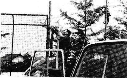
訓練用アンテナ設置
